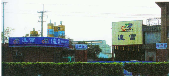
▲牌頭新廠佔地1,000坪，並擁有一條45呎完整組車線。
