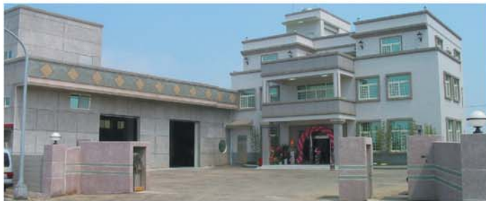
▲新廠房外觀全景。
