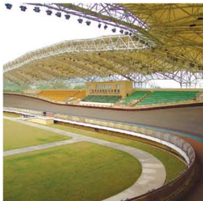
▲號稱亞洲第一的龍崗國際自行車賽場，佔地12,500平方公尺並擁有2千多個座位，賽道擁有12~45度的坡度變化。
