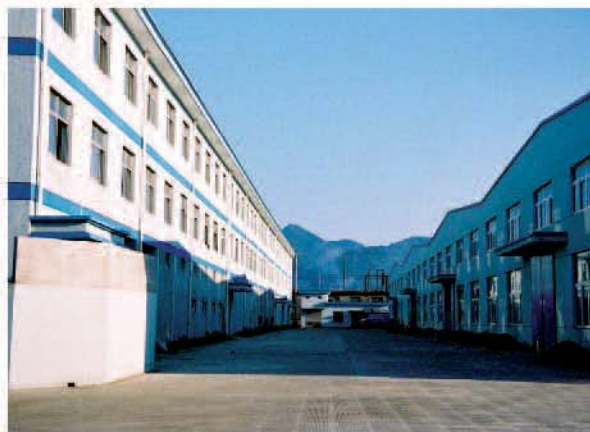
▲山雄新廠房氣派的外觀。
