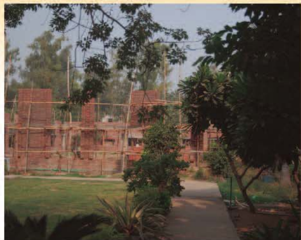
▲ ATALAS 正在增蓋的烤漆間。
