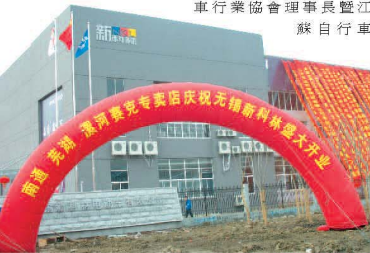
▲無錫新科林電動車有限公司廠房外觀。
