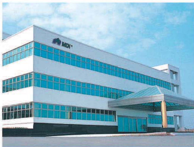
▲福隆科技廠房外觀。
