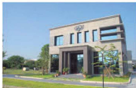
▲東芸新廠佔地近一甲，除了工廠與辦公室，未來還將興建門市與土坡場地。
