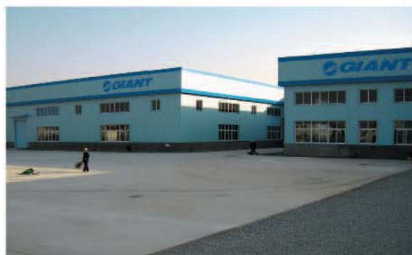
▲捷安特（天津）廠房正逐步建設中。
