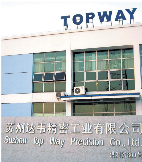
▲ 蘇州達韋公司乾淨俐落的辦公樓外觀。
