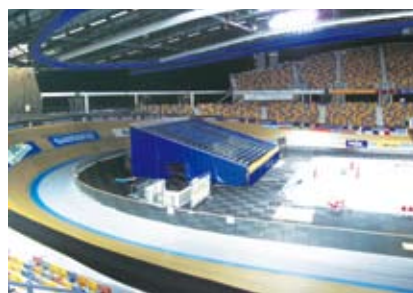
◀位於 Apeldoorn 的 Omnisport 多功能室內運動場，造價 600 萬歐元，有高水準的排球場、田徑與自行車 Track 跑道，將是 2011 年世界錦標賽 Track 場地賽的賽場。
