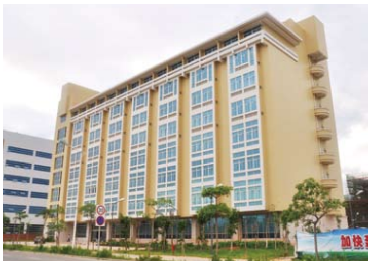
▲位於廈門湖里區的正新研發中心幾乎已完工，未來會是廈門正新最佳寶庫集散地。
