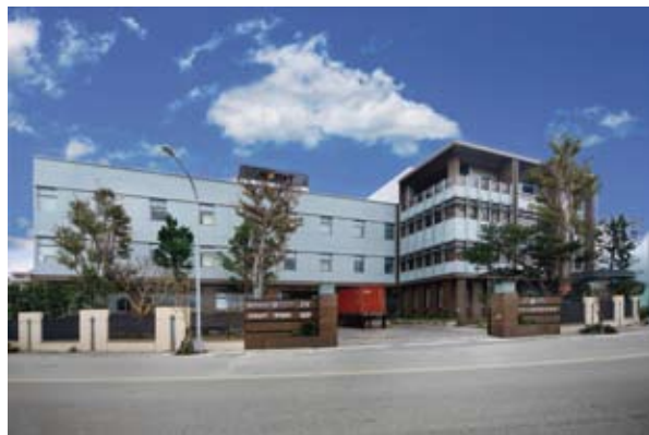
▲近三年來台萬集團在臺中市大甲區加購土地擴建廠房，圖為已經完工的第一期建築體，包含全球總部、辦公大樓和工廠。(Photo: 台萬)
