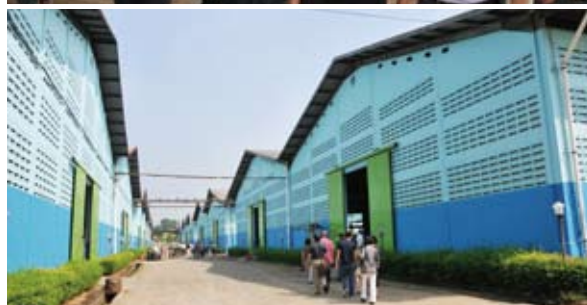
▲台萬集團於1992年到雅加達Tangerang設廠，今年剛好滿20年。佔地56,200平方米的台萬印尼廠，有8棟廠房，是集團最大的生產製造基地，員工500人，腳踏月產能達150萬組。
