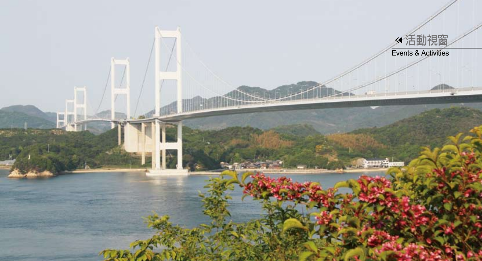
▲來島海峽大橋是一座三連式吊橋，全長4,105米，是島波海道最長的跨海大橋。
