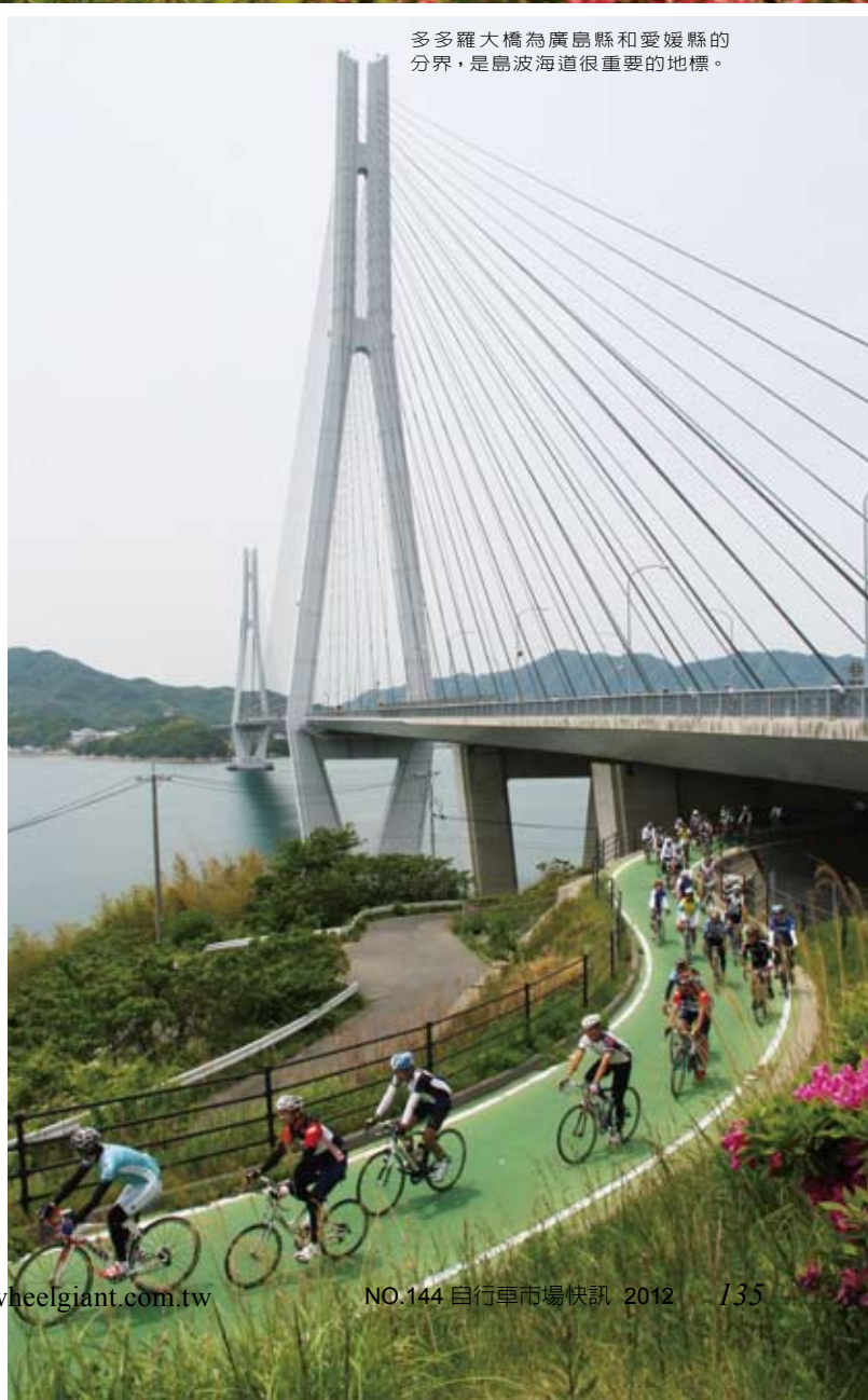
▲來島海峽大橋是一座三連式吊橋，全長4,105米，是島波海道最長的跨海大橋。
