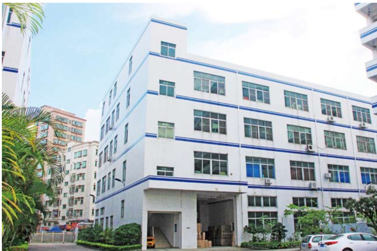
▲創新維新廠區大樓。
