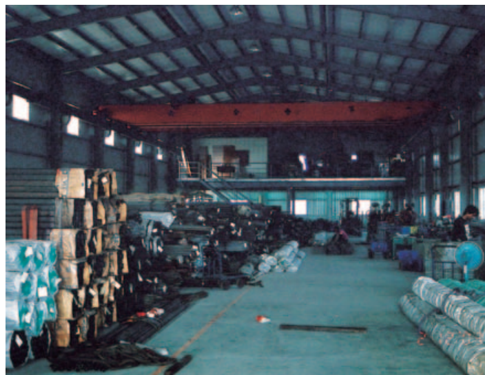
▲松宏位於埔鹽鎮南新村的新廠，佔地450坪，以每個月100公噸正式量產。
