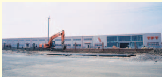
▲即將完工投產的北京榮知園天津新廠。
